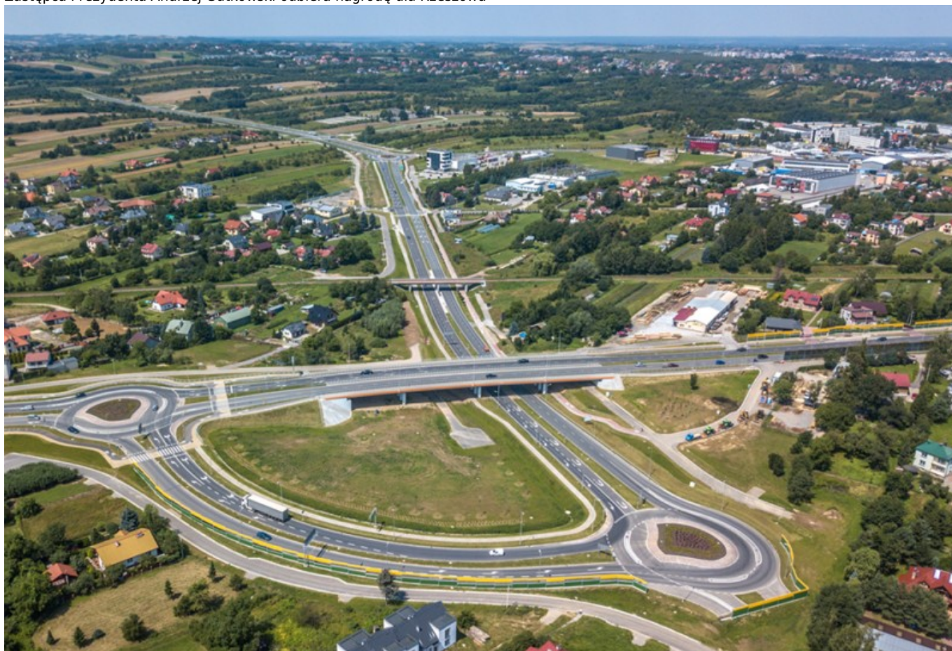
Droga wojewódzka od skrzyżowania ul. Podkarpackiej z ul. 9 Dywizji Piechoty w Rzeszowie do węzła Rzeszów-Południe 15 maja 2018 r., podczas Europejskiego Kongresu Gospodarczego w Katowicach Portalsamorządowy.pl rozdał prestiżowe wyróżnienia dla najlepszych inwestycji w Polsce w konkursie Top Inwestycje Komunalne 2018 r. Rzeszów otrzymał nagrodę za budowę drogi wojewódzkiej od skrzyżowania ul. Podkarpackiej z ul. 9 Dywizji Piechoty w Rzeszowie do węzła Rzeszów-Południe.
