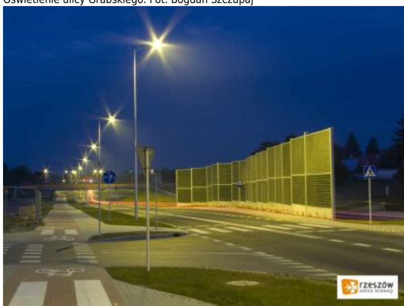
Oświetlenie połączenia ulicy Przemysłowej z Podkarpacką. Fot. Bogdan Szczupaj
