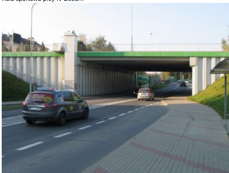
Tunel pod ul. Krakowską
