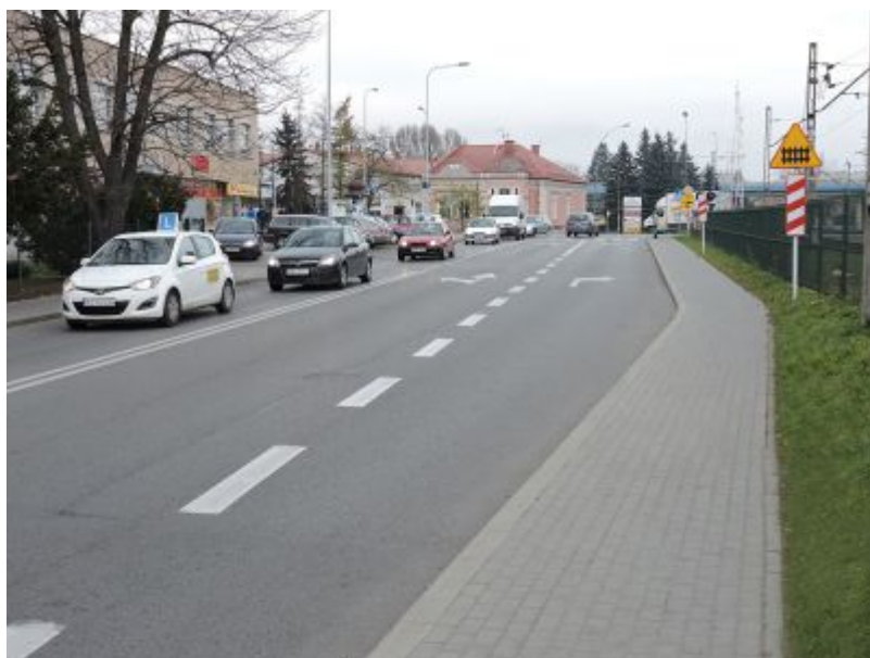
Przebudowana ul. Wyspiańskiego
