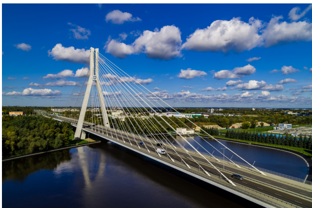
Rozbudowa węzła drogowego al. Wyzwolenia - ul. Warszawska - koszt inwestycji: 68 mln zł
