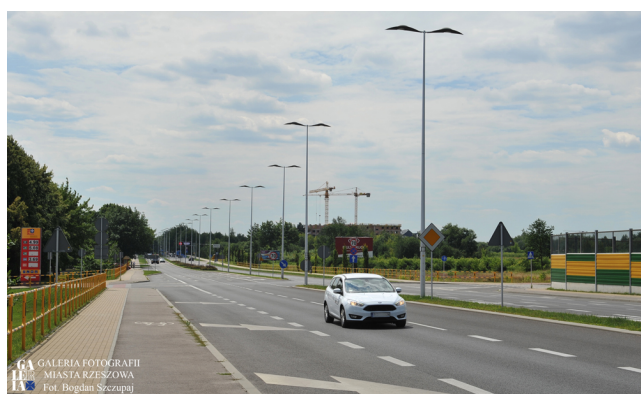
Budowa łącznika do autostrady A4
