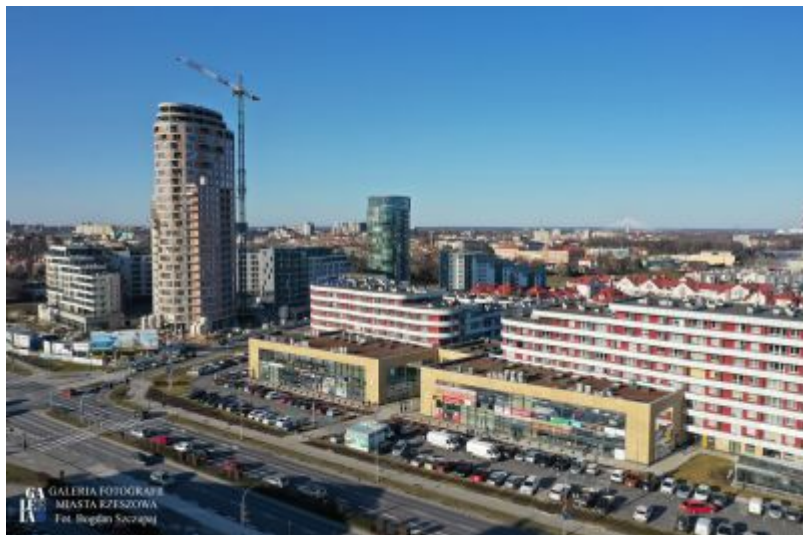
Capital Towers w budowie (2020 r.)
