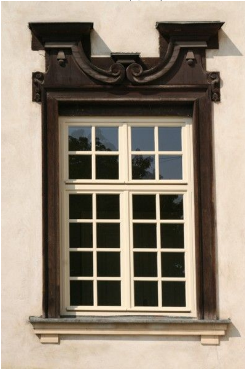
Detale architektoniczne elewacji pałacyku
