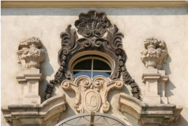
Detale architektoniczne elewacji pałacyku
