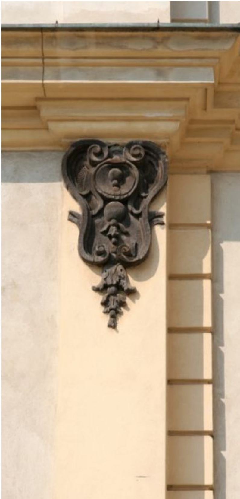
Detale architektoniczne elewacji pałacyku
