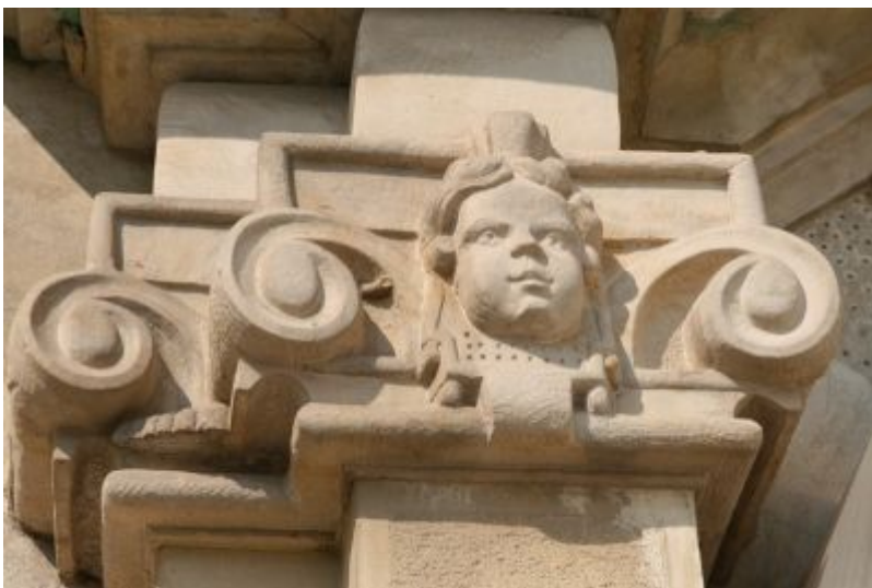
Detale architektoniczne elewacji pałacyku
