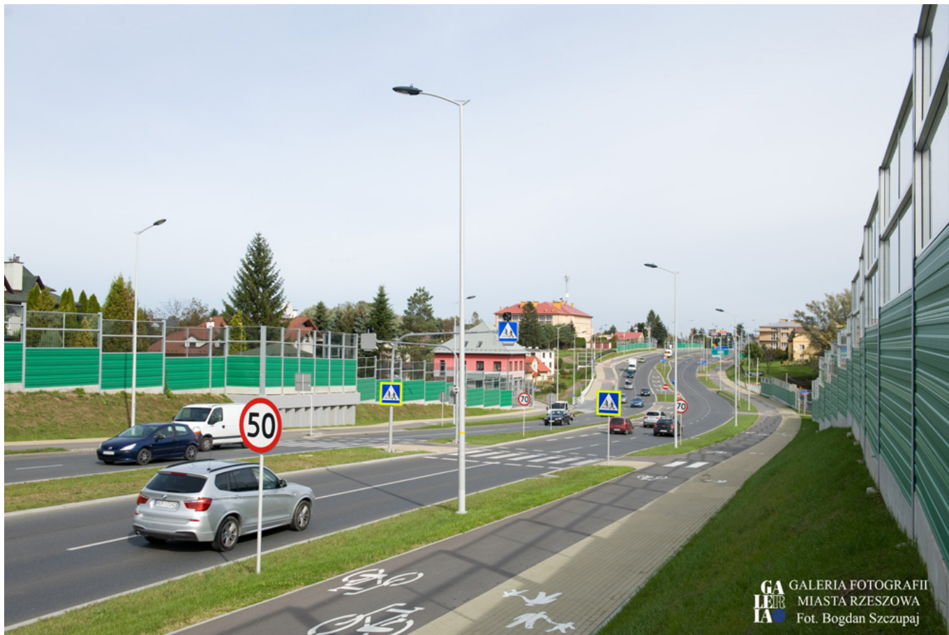
Zmodernizowana ulica Podkarpacka
