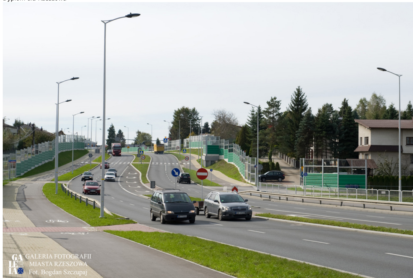
Zmodernizowana ulica Podkarpacka
