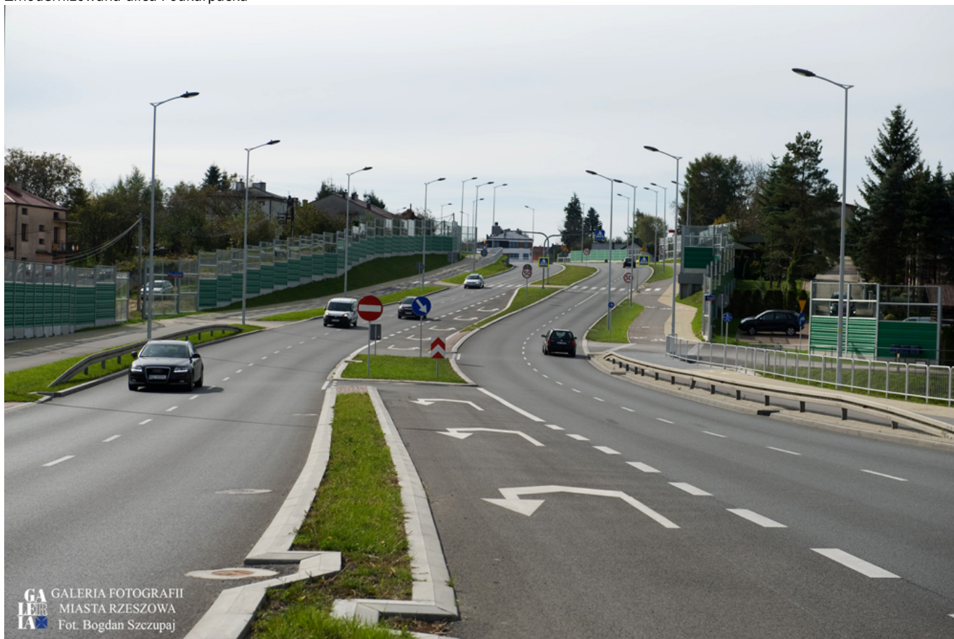
Zmodernizowana ulica Podkarpacka
