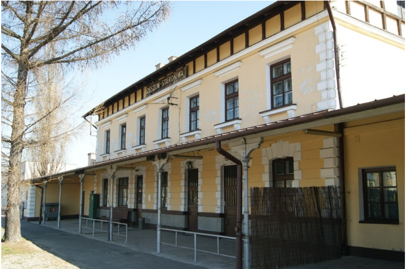
Stacja Rzeszów - Staroniwa
