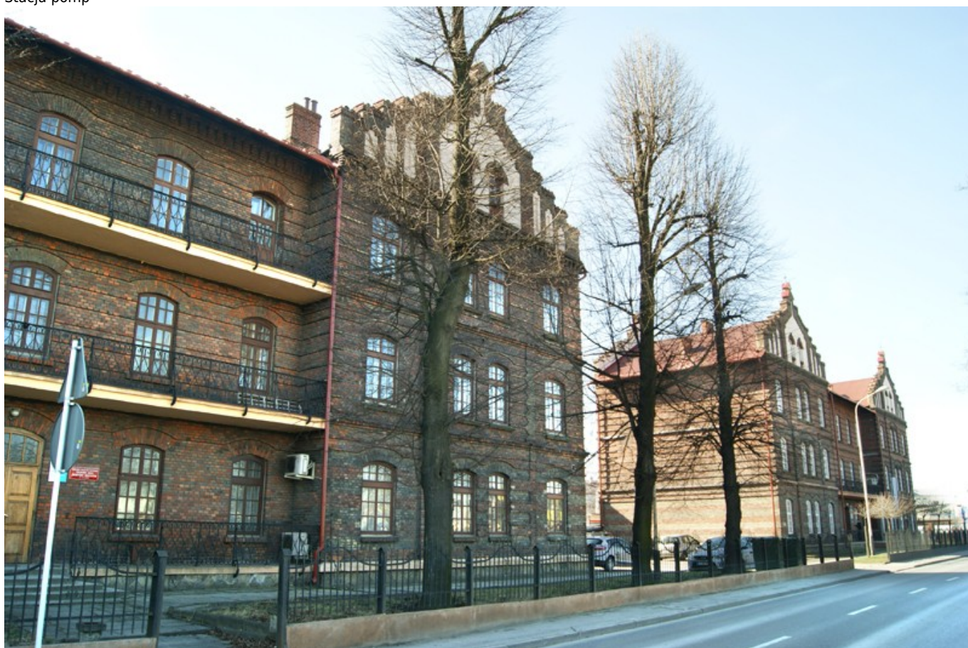
Budynek Dyrekcji Kolei
