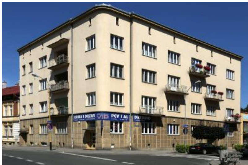
Kamienica czynszowa w narożniku ulic Asnyka i Sobieskiego, wybudowana pod wynajem dla dyrektorów Wytwórni Silników nr 2 Państwowych Zakładów Lotniczych w Rzeszowie. J. Mackiewicz, K. Holzer, 1937-38.
