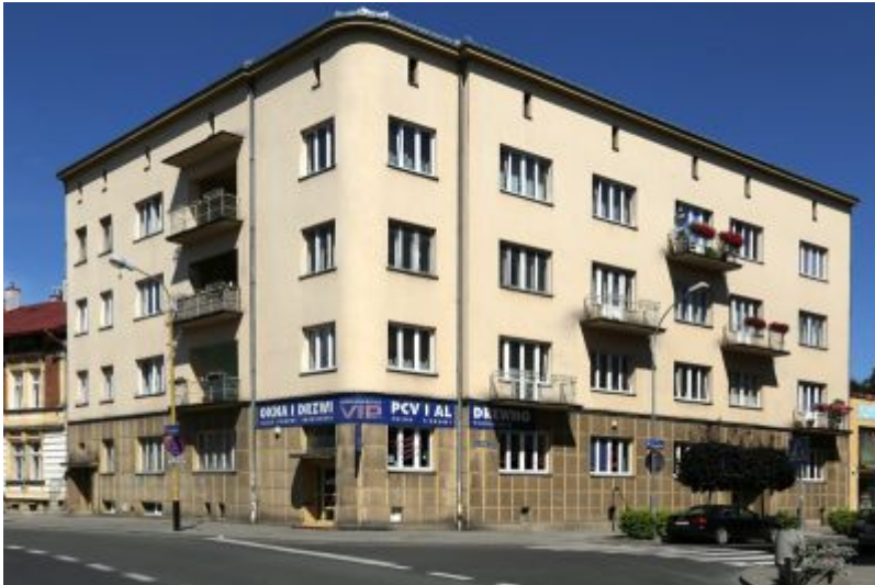
Kamienica czynszowa w narożniku ulic Asnyka i Sobieskiego, wybudowana pod wynajem dla dyrektorów Wytwórni Silników nr 2 Państwowych Zakładów Lotniczych w Rzeszowie. J. Mackiewicz, K. Holzer, 1937-38.
