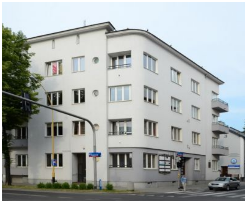
Dom w narożu ul. Szopena i Naruszewicza nawiązujący do architektury statkowej, z nautycznymi oknami typu bulaj oraz opływowymi narożami. S. Keil, 1938 r.
