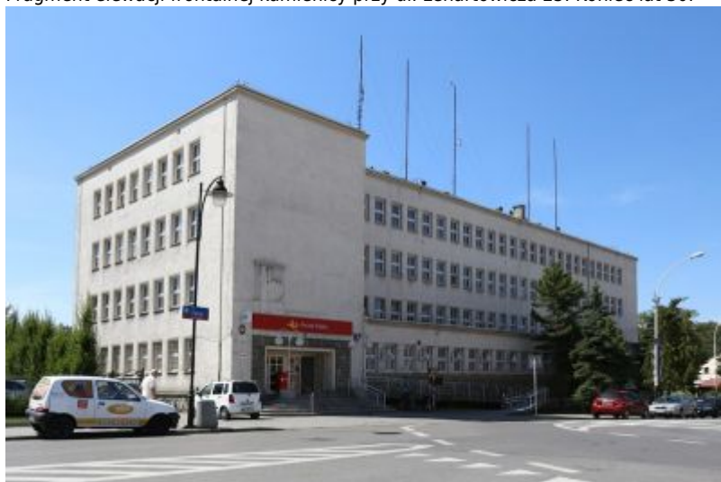
Urząd pocztowy przy ul. Moniuszki 1, prezentujący kompozycję przenikających się brył geometrycznych. 1939 r.
