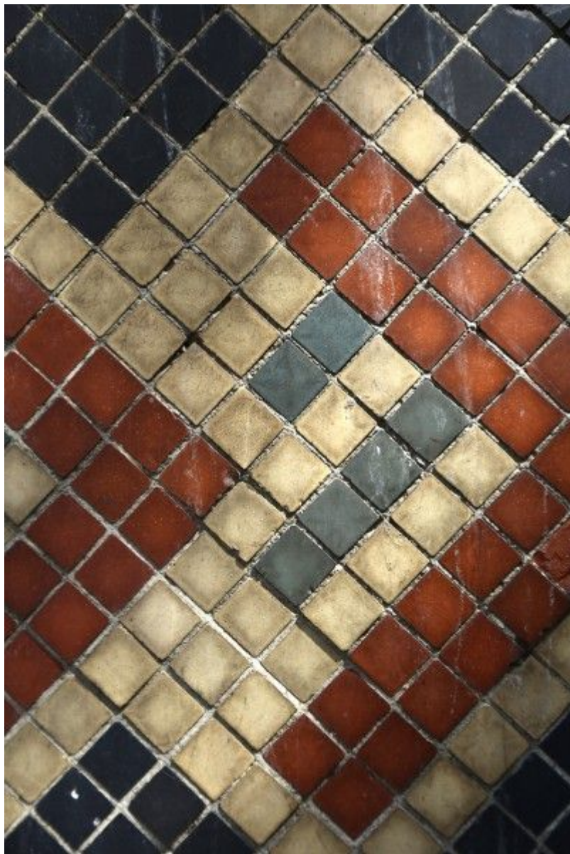
Fragment elewacji frontalnej kamienicy przy ul. Lenartowicza 25. Koniec lat 30.
