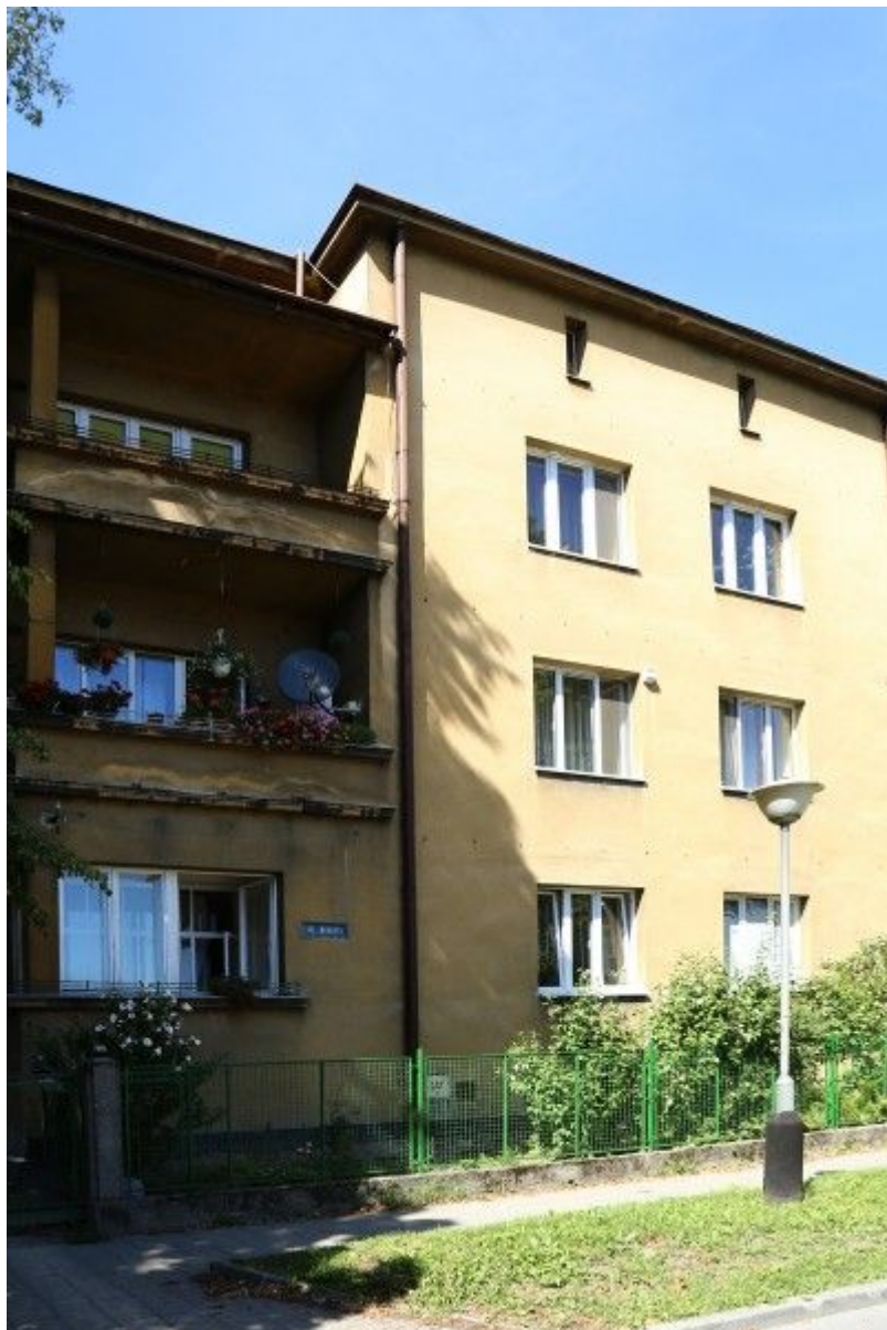
Willa przy ul. Dekerta 1 z typowymi dla architekta domu narożnymi loggiami widokowymi na Aleję Pod Kasztanami oraz Zamek Lubomirskich. Na elewacjach zachowały się oryginalne tynki szlachetne z dodatkiem miki. K. Holzer, 1936-37.
