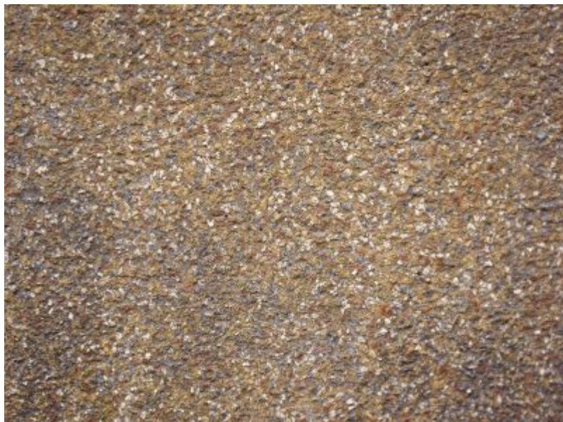
Fragment ozdobnego tynku szlachetnego z użyciem pigmentu i barwnego kruszywa, kamienica ul. Jagiellońska 12.
