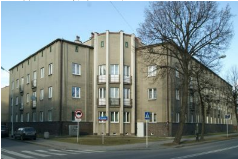
Dom Funduszu Kwaterunku Wojskowego w narożniku ulic: Szopena i Leszczyńskiego z charakterystycznymi elewacjami licowanymi czerwoną i szarą cegłą, koniec lat 30.
