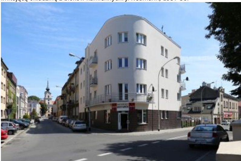
Dom-stątek przy ul. Kraszewskiego 7 z końca lat 30. Obecny wygląd budynku zawdzięcza się trafnemu przywróceniu jego pierwotnej, jasnej kolorystyki, wpisującej się w genius loci architektury modernistycznej.
