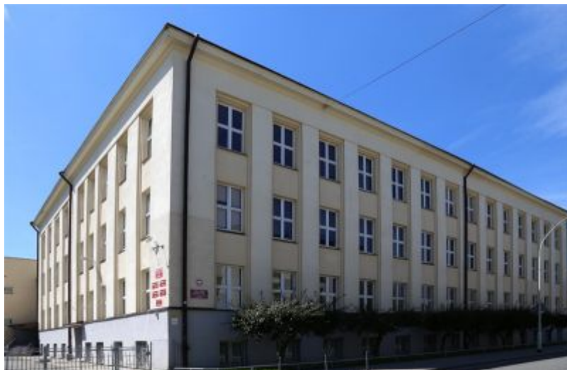
Budynek dawnej Szkoły Przemysłowej Zeñskiej, obecnie Zespołu Szkół Ekonomicznych o gęstej artykulacji wysmukłych lizen ożywiających "płaskie" elewacje. Ul. Hoffmanowej 13, P. Emilewicz, 1930
