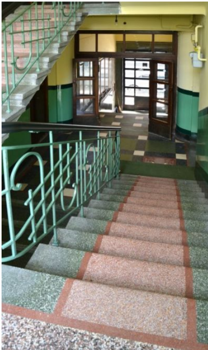
Klatka schodowa kamienicy przy ul. Jagiellońskiej 12 wyłożona barwionym, szlifowanym lastrikiem. We wnętrzu zachowała się również metalowa balustrada oraz stolarka drewniana ze szkłem kryształowym.
