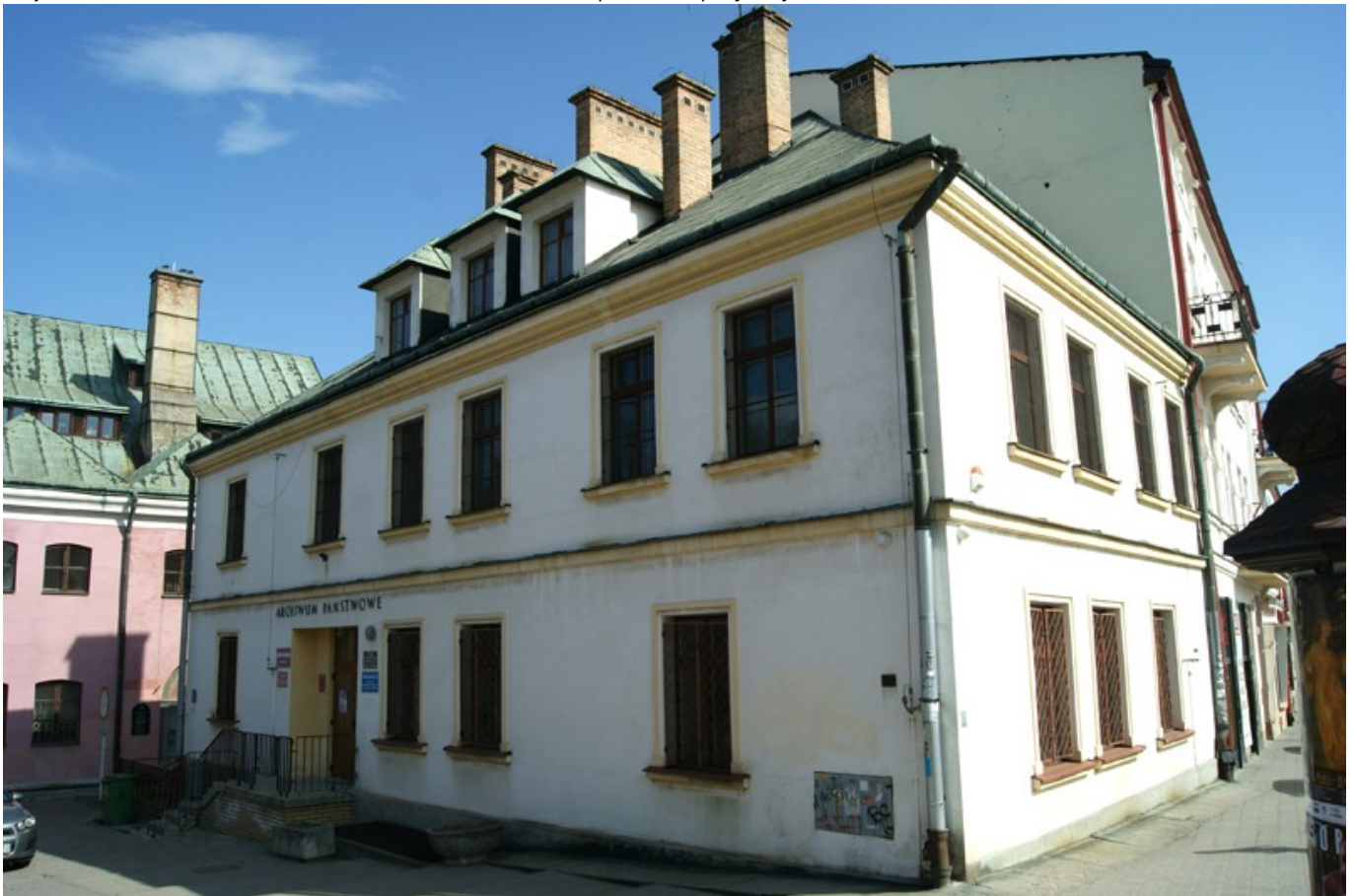
Budynek danej szkoły żydowskiej przy obecnej ul. Bożniczej
