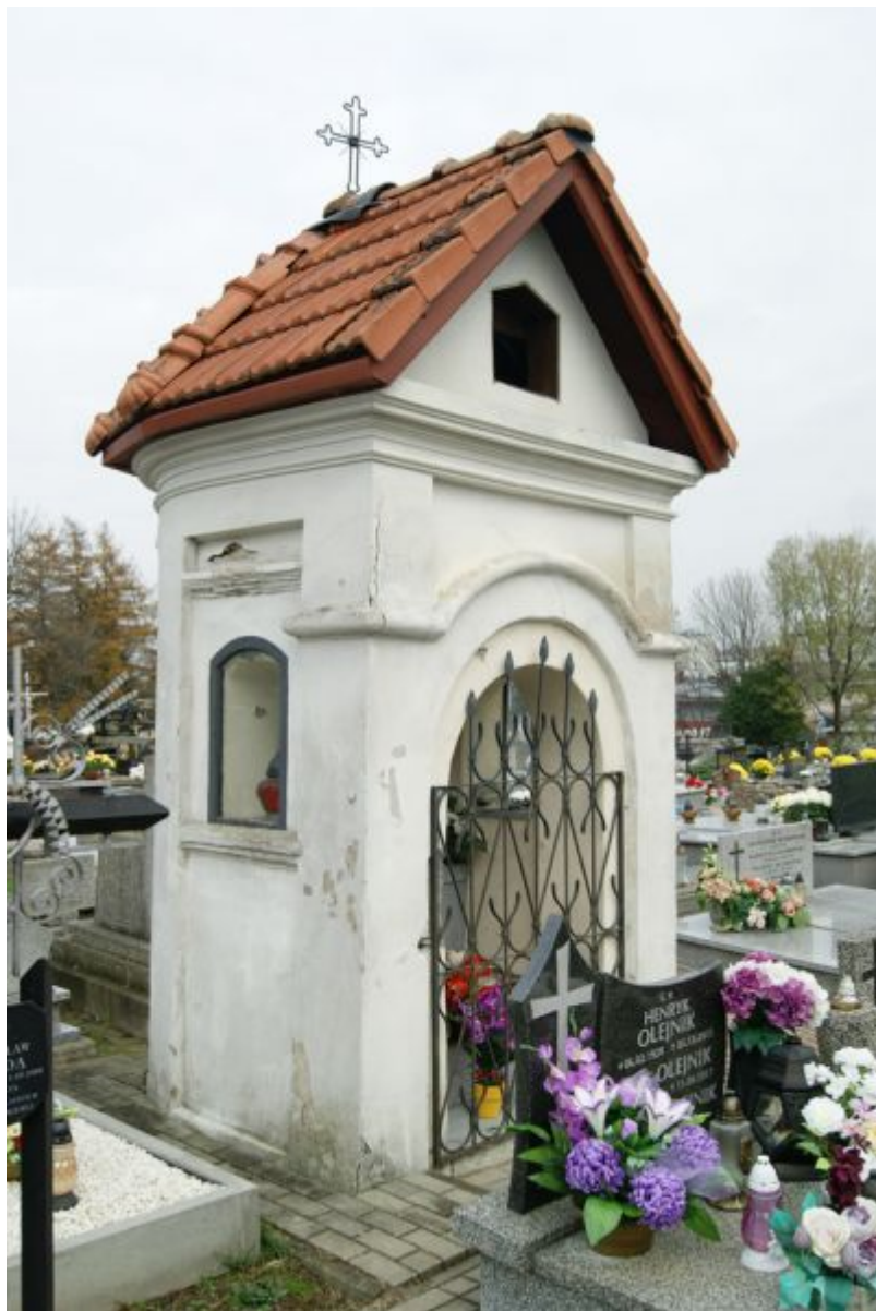
Wybudowana z cegły na przełomie XVII i XVIII wieku niewielka, otwarta kaplica cmentarna
