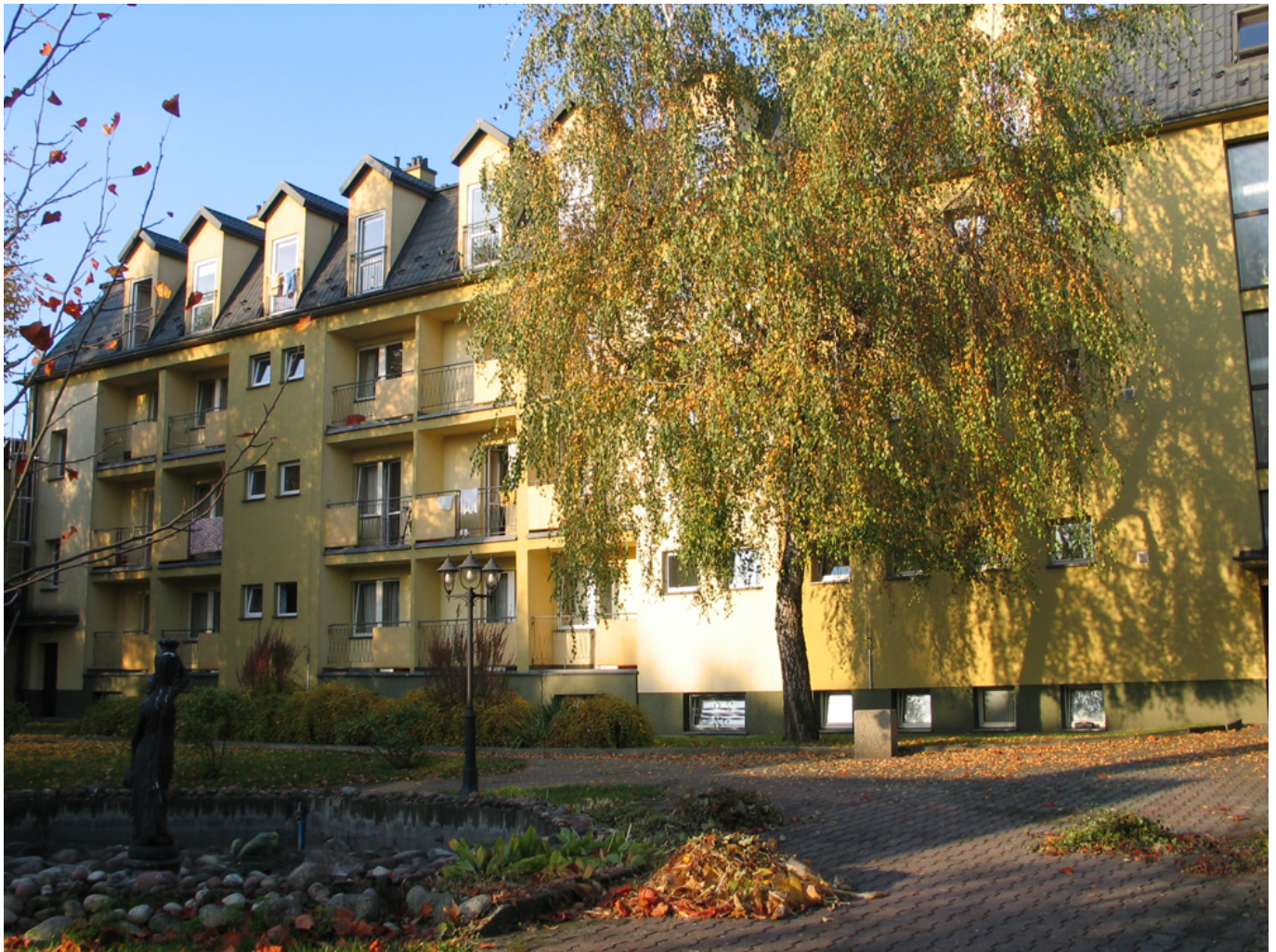
DPS przy ul. Sucharskiego
