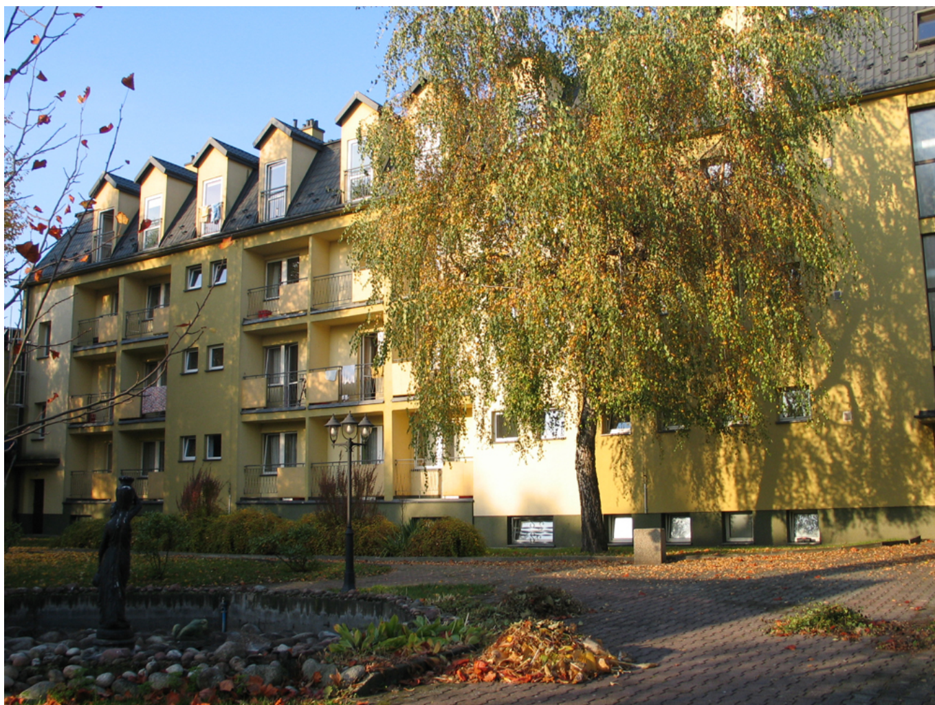
DPS przy ul. Sucharskiego
