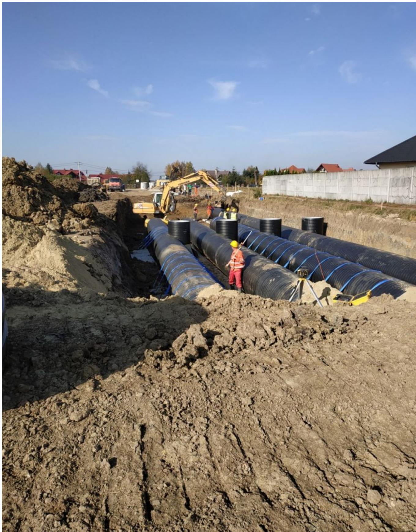
Budowa kanalizacji na Budziwoju
