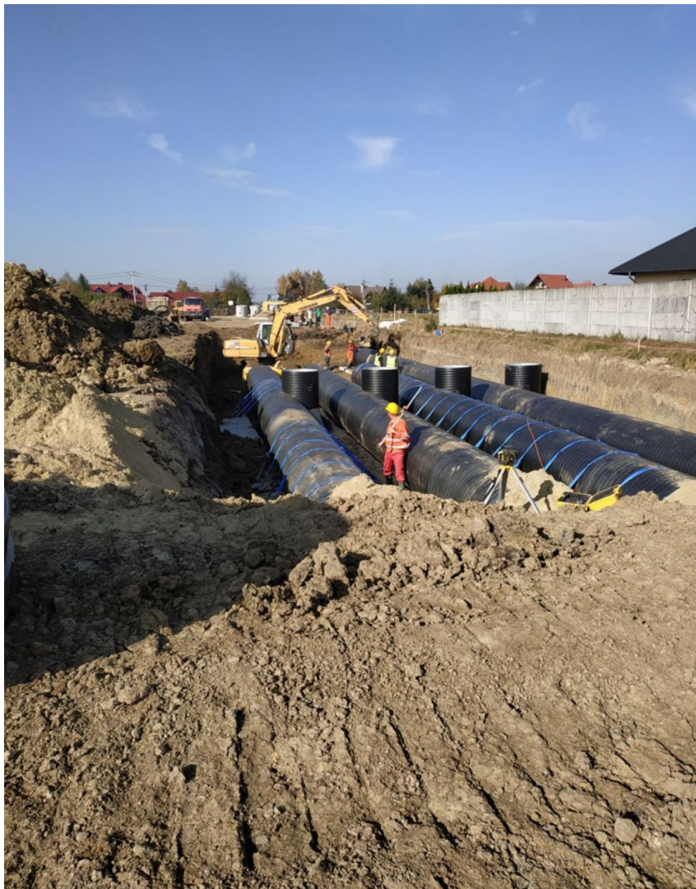
Budowa kanalizacji na Budziwoju
