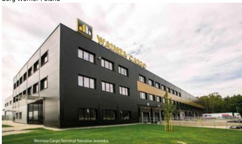
Weimea Cargo Terminal Rzeszów Jasionka
