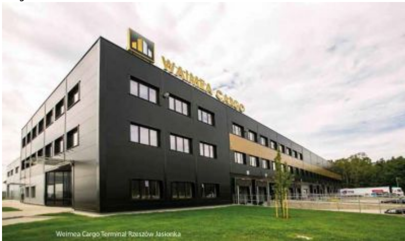
Weimea Cargo Terminal Rzeszów Jasionka
