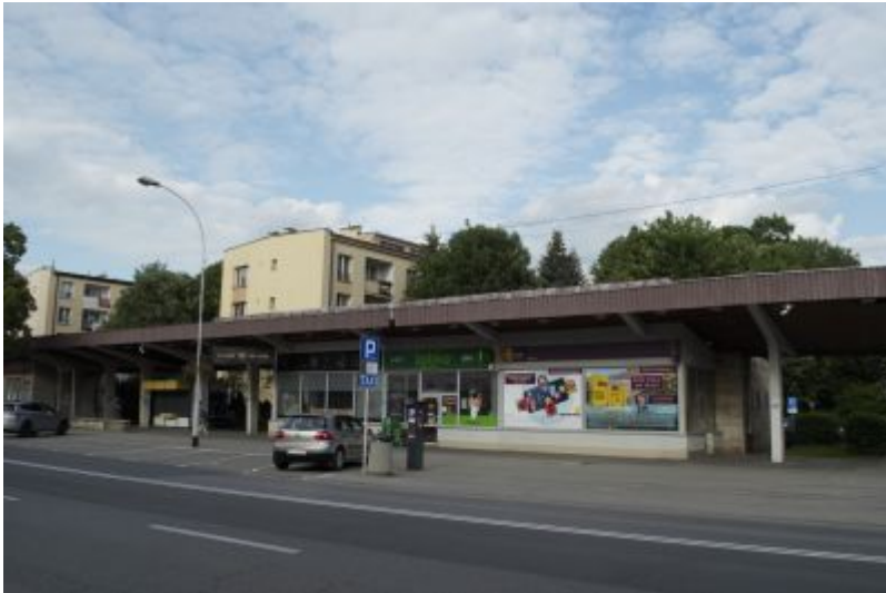
Pawilon przy ul. Hetmańskiej 31, przekształcony. Oryginalne przeszklenie elewacji zostało zlikwidowane i zastąpione oknami z PCV, powielającymi historyczny pas przeszklonej płaszczyzny, tworzonej przez prostokątne kwatery. Ściany pawilonu są otynkowane a cokół obłożony płytkami ceramicznymi. Fot. Ludmiła Łapka
