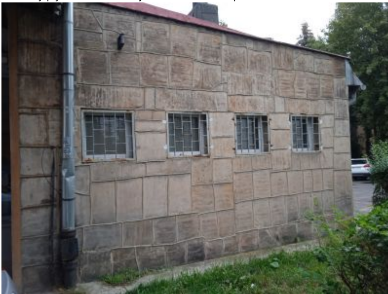
Południowa ściana zalepcza pawilonu przy ul. Hetmańskiej 31 zachowuje dekoracyjną okładzinę cementową z wydatnymi spoinami oraz oryginalne metalowe kratki okienne. Zdjęcie BMKZ UM Rzeszowa
