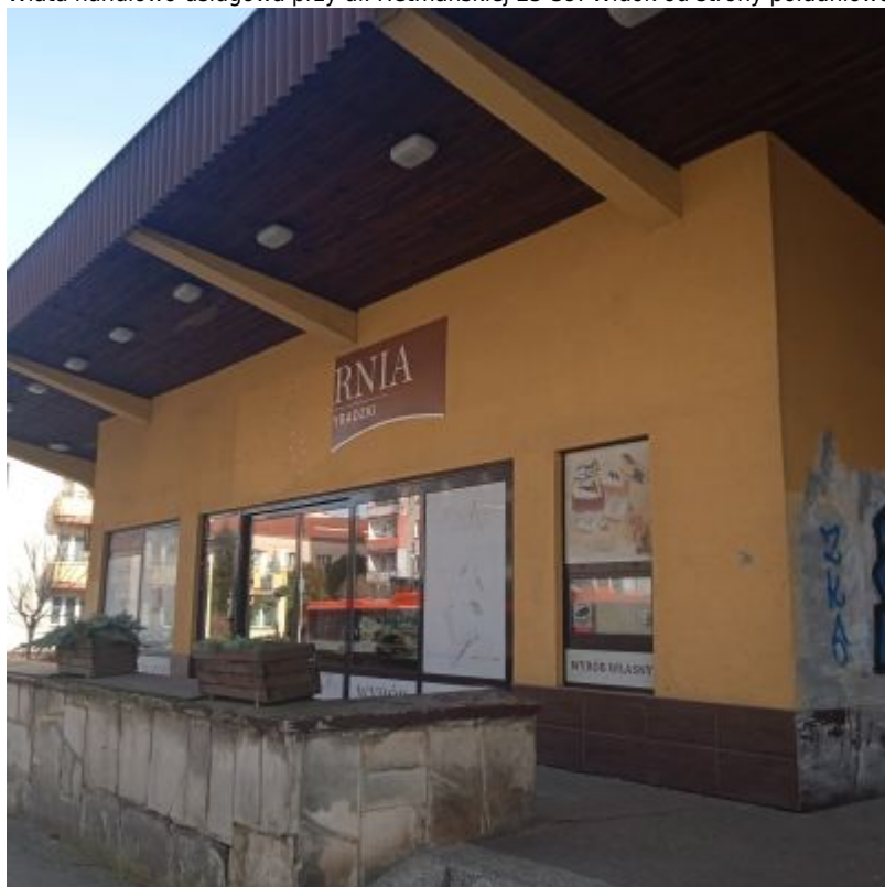
Pawilon przy ul. Hetmańskiej 25, powstały wtórnie, najprawdopodobniej w latach 90. XX wieku, w wyniku zabudowania trzech z pięciu filarów poprzedzających pierwszy pawilon od strony północno-wschodniej. Przed pawilonem widoczny zachowany niski mурowany murek w kształcie litery 'L', z dłuższym bokiem równoległym do ulicy, z obrzutką cementową o wydatnych, profilowanych spoinach, imitującą nieregularny łamany kamień. Zdjęcie BMKZ UM Rzeszowa
