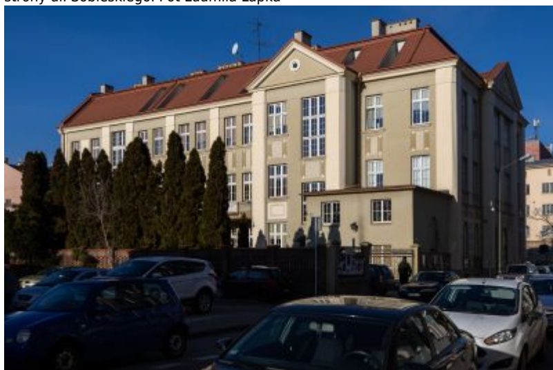
Żydowski Dom Ludowy z lat 1926-1929, obecny Wojewódzki Dom Kultury przy ul. Okrzei 7. Widok współczesny na elewację południową od strony ul. Okrzei. Fot. Grzegorz Bukała
