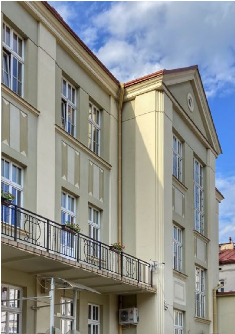
Fragment elewacji południowej od ul. Kopernika. Widoczne elementy zmodernizowanego klasycyzmu (międzyosiowe pilastry zastosowane w wielkim porządku) i zgeometryzowanej dekoracji płycinowej w pasach międzyokiennych. Fot. Ludmiła Łapka
