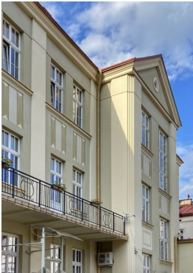
Fragment elewacji południowej od ul. Kopernika. Widoczne elementy zmodernizowanego klasycyzmu (międzyosiowe pilastry zastosowane w wielkim porządku) i zgeometryzowanej dekoracji płycinowej w pasach międzyokiennech. Fot. Ludmiła Łapka
