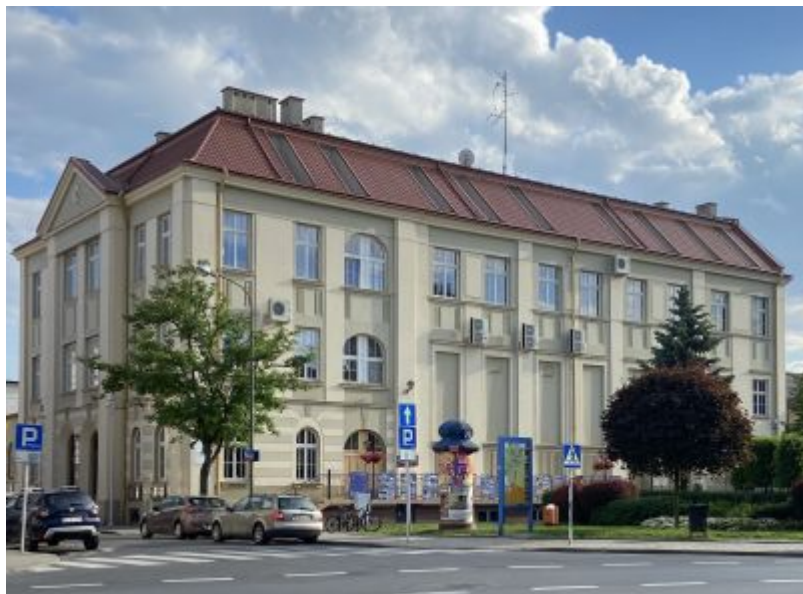
Żydowski Dom Ludowy z lat 1926-1929, obecny Wojewódzki Dom Kultury przy ul. Okrzei 7. Widok współczesny na elewację północną od strony ul. Sobieskiego. Fot. Ludmiła Łapka
