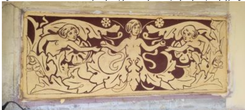
Sgraffito w trakcie rekonstrukcji. Wydrapywanie rysunku przy użyciu precyzyjnego ryłca(ul. Sobieskiego 5). Fot. ze zbiorów autorki
