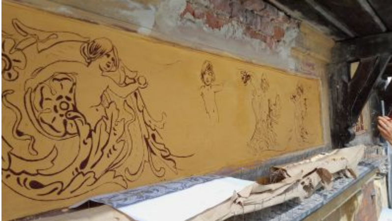
Sgraffito w trakcie rekonstrukcji. Wydrapywanie rysunku przy użyciu precyzyjnego ryłca(ul. Sobieskiego 5). Fot. ze zbiorów autorki
