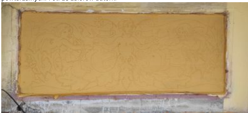
Etap poprzedzający rekonstrukcję sgraffita na obiekcie. Widać rysunek naniesiony metodą przepiórczy na świeżą jeszcze warstwę pobiąły (ul. Sobieskiego 5). Fot. ze zbiorów autorki
