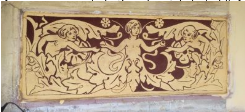
Sgraffito w trakcie rekonstrukcji. Wydrapywanie rysunku przy użyciu precyzyjnego ryłca(ul. Sobieskiego 5). Fot. ze zbiorów autorki
