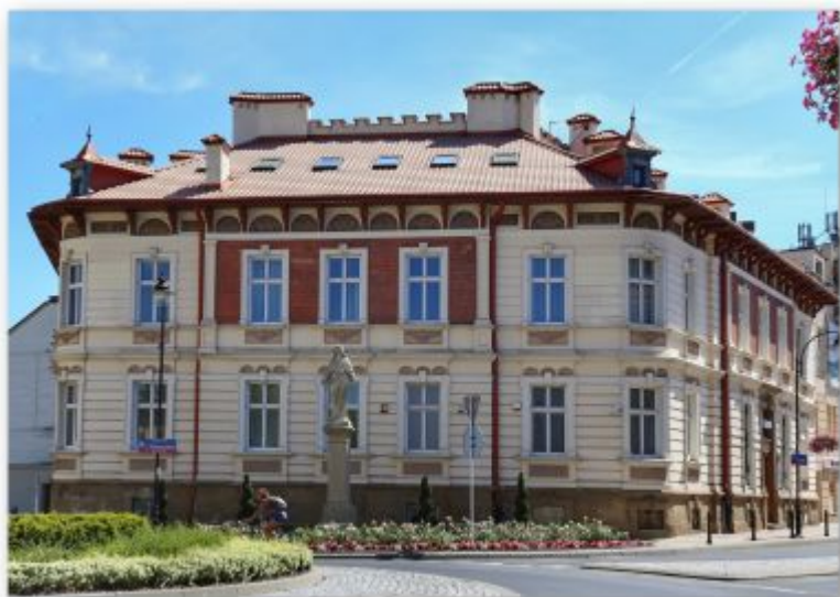
Kamienica przy ul Sokoła 6 w Rzeszowie z dwubarwną dekoracją fryzu koronnego wykonaną w technice sgraffita. Fot. ze zbiorów Biura Miejskiego Konserwatora Zabytków
