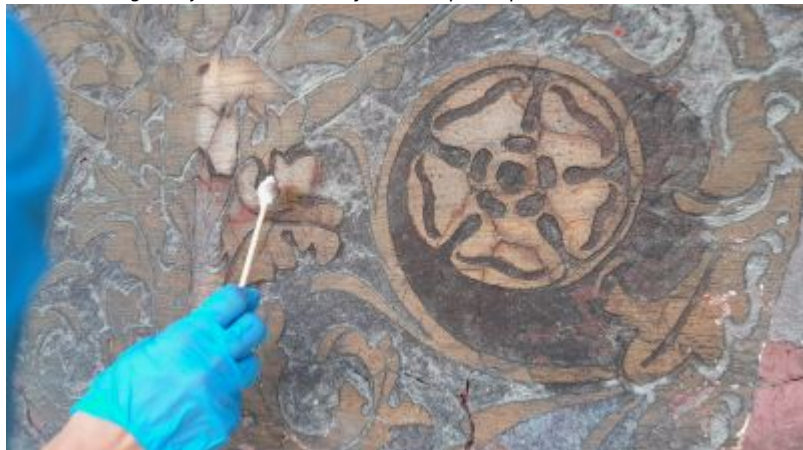
Próby chemicznego usuwania szarni z powierzchni sgraffita (ul. Sobieskiego 5). Fot. ze zbiorów autorki
