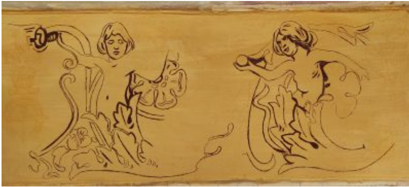
Sgraffito w trakcie rekonstrukcji. Wydrapywanie rysunku przy użyciu precyzyjnego ryłca (ul. Sobieskiego 5). Fot. ze zbiorów autorki
