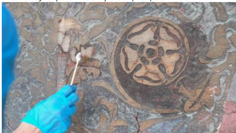
Próby chemicznego usuwania szarni z powierzchni sgraffita (ul. Sobieskiego 5). Fot. ze zbiorów autorki
