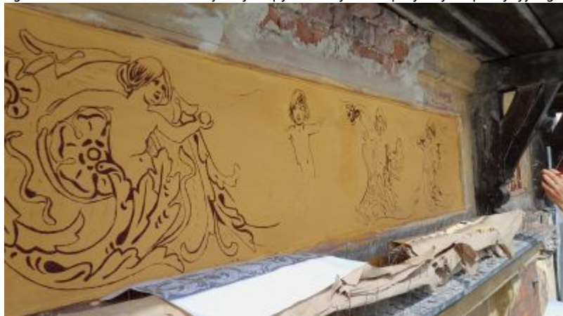
Sgraffito w trakcie rekonstrukcji. Wydrapywanie rysunku przy użyciu precyzyjnego ryłca(ul. Sobieskiego 5). Fot. ze zbiorów autorki
