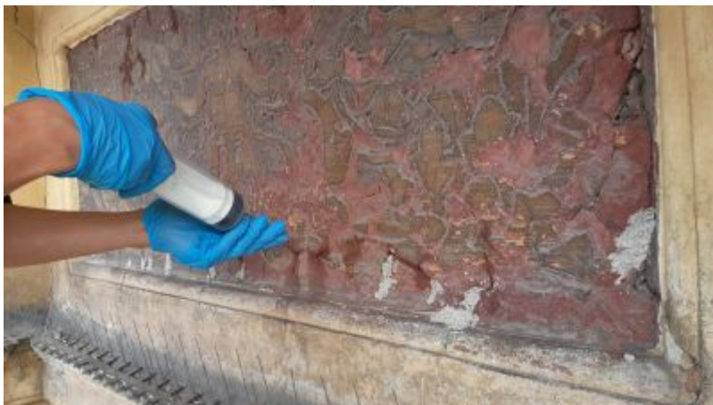
Wykonywanie iniekcji tj. podklejanie odspojonych partii oraz niwelowanie istniejących rozwarstwień (ul. Sobieskiego 5). Fot. ze zbiorów autorki
