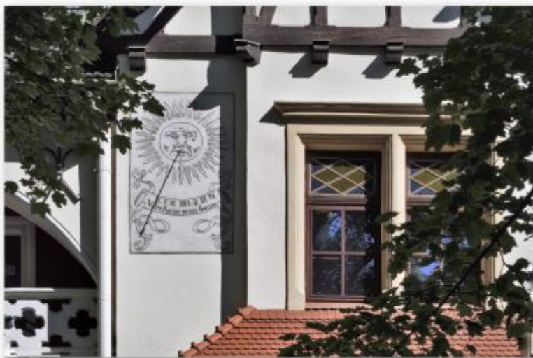
Fragment elewacji malowniczej willi Tadeusza Tekielskiego z Alei Pod Kasztanami 10 ukazujący zegar słoneczny wykonany w technice sgraffito. Fot. Ludmiła Łapka
