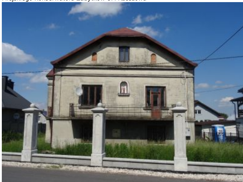
Dom zwany "Belwederem" oraz "kamienicą Micalików" przy ul. Pogwizdowskiej 184. Widok od ulicy od strony południowo-zachodniej. Materiały Biura Miejskiego Konserwatora Zabytków UM Rzeszowa
