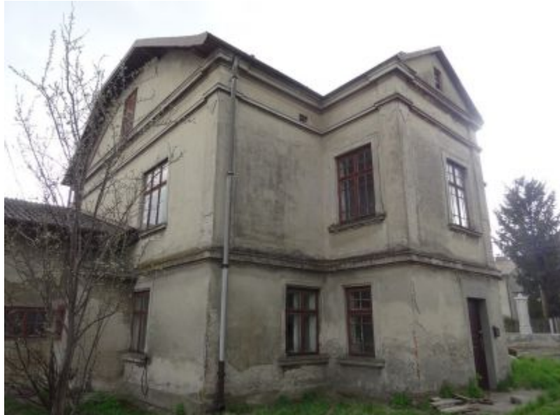
Dom zwany "Belwederem" oraz "kamienicą Micalików" przy ul. Pogwizdowskiej 184. Widok od podwórza od strony północnej. Materiały Biura Miejskiego Konserwatora Zabytków UM Rzeszowa
