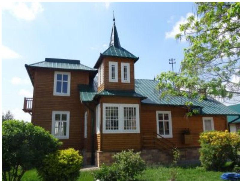
Zabytkowy dom właściciela młyna przy ul. Łąkowej 6, widok od południowego wschodu. Materiały Biura Miejskiego Konserwatora Zabytków UM Rzeszowa
