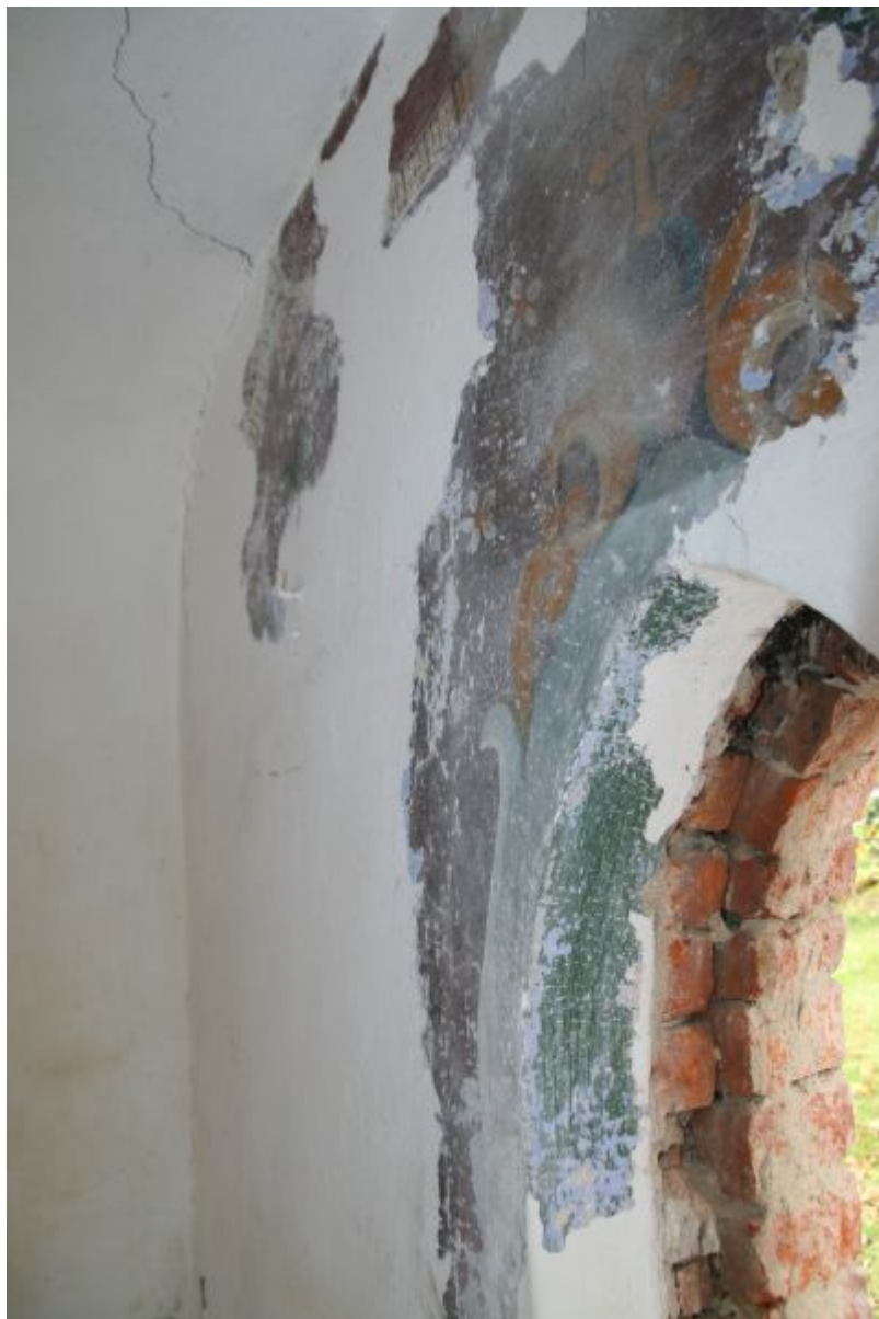
Polichromia w trakcie jej odsłaniania spod wtórnych powłok malarskich
