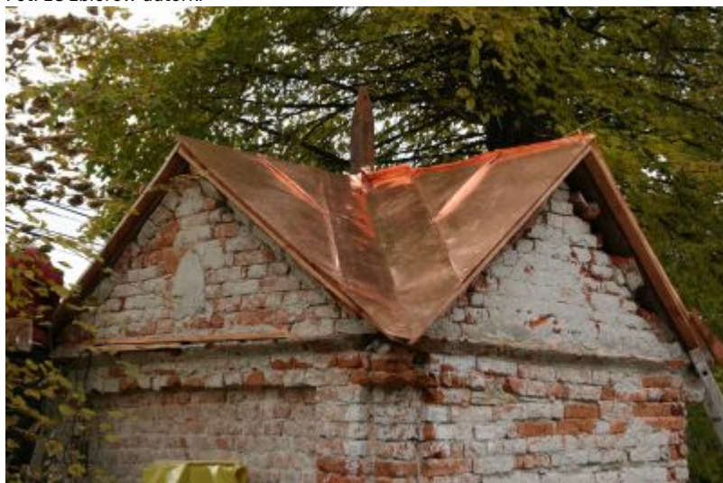
Odtworzone metodą rzemieślniczą pokrycie dachowe. Krycie wykonano blachą miedzianą "na felc" zgodnie z pierwotną technologią. Fot. ze
