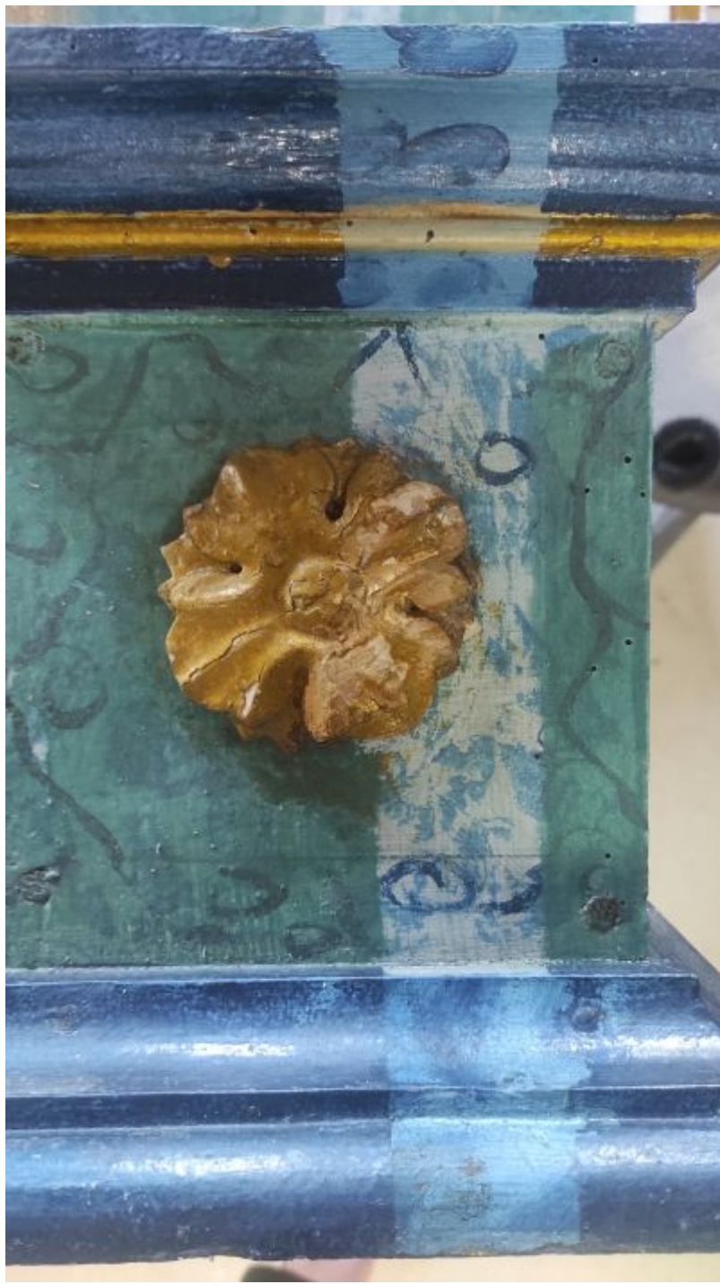
Fragment ołtarzyka ukazujący odkrywkę pasową z czytelną, dobrze zachowaną oryginalną warstwą marmoryzacji tj. imitacji marmuru wykonanej w technice malarskiej na drewnianej strukturze. Fot. ze zbiorów autorki
