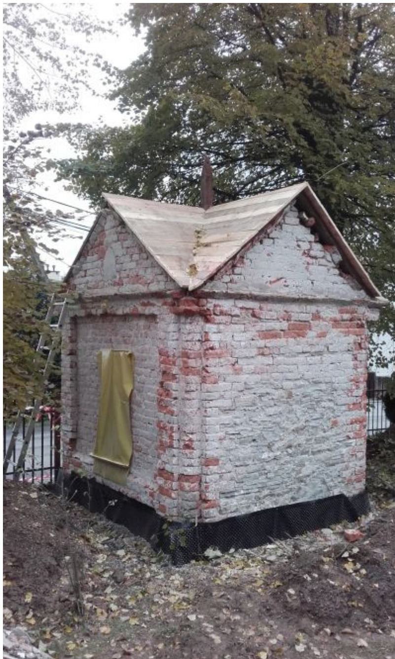
Etap konserwacji technicznej. Wykonano izolację pionową i poziomą, skuto zdestruowane, zawilgocone i zagrzybione tynki. Mury zostały osuszone, poddane dezynfekcji, dezynsekcji oraz wzmocnione poprzez impregnację. Zdjęto nieoryginalne i nieszczelne pokrycie dachowe. Fot. ze zbiorów autorki
