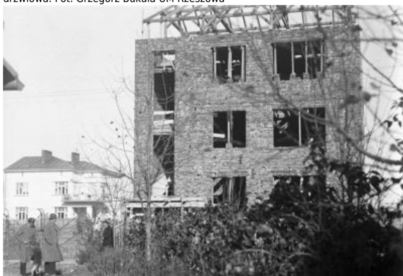
Fotografia z rodzinnego archiwum ukazująca budowę trzeciego z kolei domu Januszy, tj. modernistycznej kamienicy przy ul. Poniatowskiego 10. Zwraca uwagę, że nowy dom został wybudowany w granicy posesji należącej do willi Fryderyka, którą widzimy w tle. Zdjęcie ze zbiorów Galerii Fotografii Miasta Rzeszowa
