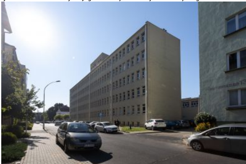
W miejscu rozebranej w latach 70. XX wieku "Janusówki" stoi dziś skrzydło Przychodni Specjalistycznej Nr 3 przy ul. Hoffmanowej 8a. Fot. Grzegorz Bukała UM Rzeszowa
