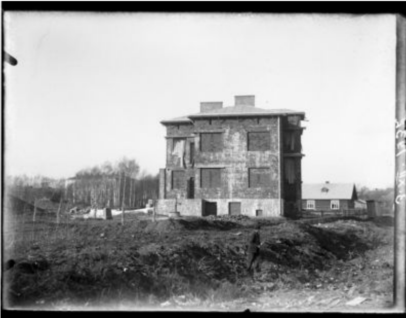
Zdjęcie z budowy willi Fryderyka Janusza, obecnie siedziby Estrady Rzeszowskiej przy ul. Jagiellońskiej 24, wykonane 3 grudnia 1932 roku. Fotografia przedstawia budynek jeszcze w stanie surowym. W tle widoczny drewniany dom, który obrazuje, w jak tradycyjnej i skromnej zabudowie przedmieścia miały miejsce pierwsze próby unowocześnienia pejzażu architektonicznego miasta. Zdjęcie ze zbiorów Galerii Fotografii Miasta Rzeszowa
