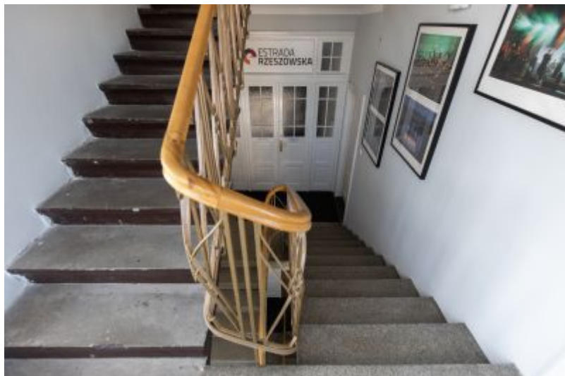
Wnętrze klatki schodowej willi Fryderyka Janusza. Widoczna balustrada w stylu art-déco, stopnie wyłożone lastriko oraz szlachetna stolarka drzwiowa. Fot. Grzegorz Bukała UM Rzeszowa
