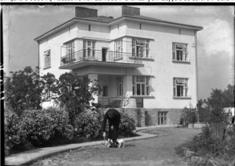
Ukończony dom Fryderyka Janusza na archiwalnej fotografii rodzinnej. Zdjęcie wykonane od strony południowej ukazuje eksponowane na słońce elewacje południowo-wschodnią i południowo-zachodnią, powiązane obszernym narożnym podcieniem na parterze i usytuowanym nad nim tarasem. Świadome projektowanie pokoi dziennych po najbardziej nasłonecznionej stronie oraz wiązanie mieszkania z naturalnym
