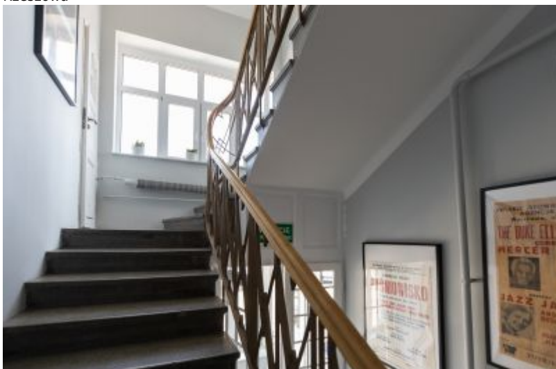
Wnętrze klatki schodowej willi Fryderyka Janusza. Usytuowana po północno-wschodniej stronie domu, tj. poza obrębem części dziennej, komunikowała parter z piętrem w taki sposób, że obydwa poziomy mogły funkcjonować w sposób od siebie niezależny. Zastosowana tu powtarzalność rozwiązań była również bardzo nowoczesna. Fot. Grzegorz Bukała UM Rzeszowa
