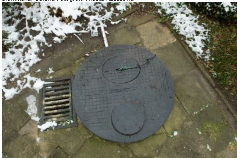
Pokrywa studni wykonana w odlewni żelaza Salomona Zweiga znajdująca się w podwórzu kamienicy przy ul. Króla Augusta 19. Fot. Bogdan Szczupaj, Pola Antonina Słomińska, Galeria Fotografii Miasta Rzeszowa
