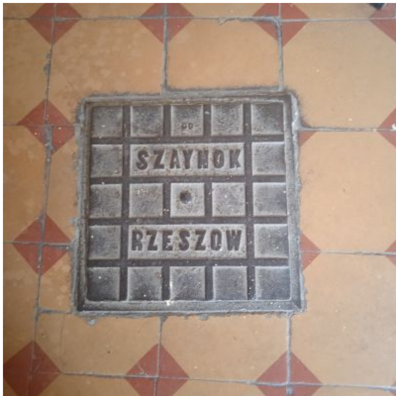
Prostokątny właz wyprodukowany w fabryce Józefa Szaynoka, znajdujący się na parterze kamienicy przy Plac Śreniawitów 2. Ze zbiorów Biura Miejskiego Konserwatora Zabytków
